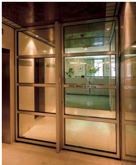
De tussenlagen zetten uit rond 120° C en vormen een stijf en ondoorzichtig scherm.
